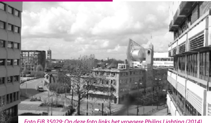
Foto EiB 35029: Op deze foto links het vroegere Philips Lighting (2014).
