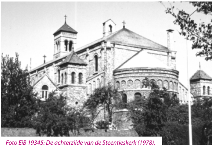
Foto EiB 19345: De achterzijde van de Steentjeskerk (1978).
