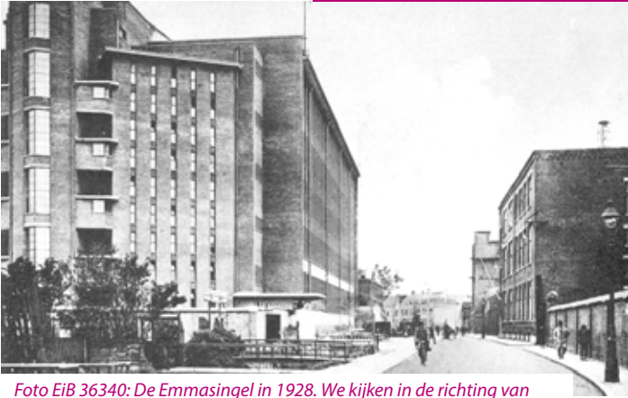
Foto EiB 36340: De Emmasingel in 1928. We kijken in de richting van de Willemstraat. Aan de linkerkant van de straat de bruggetjes over de stadsgracht/de Gender.
