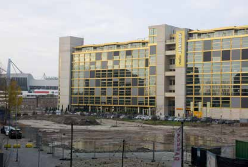
Foto EiB 54690 (*): Het toekomstige Victoriapark. Vroeger stond hier ook het Philips Lighting Application Centre dat afgebrand is in 2023.
