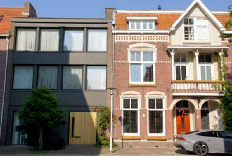
Foto EiB 53437 (*): Een oude en moderne gevel in de Sint Catharinastraat.
