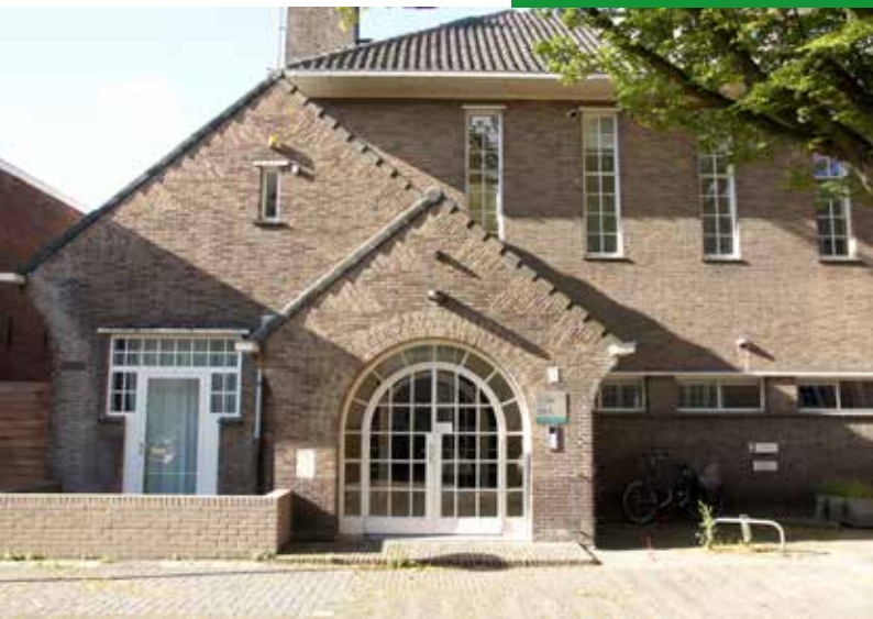
Foto EiB 53448 (*): De ingang van het vroegere schoolgebouw.
