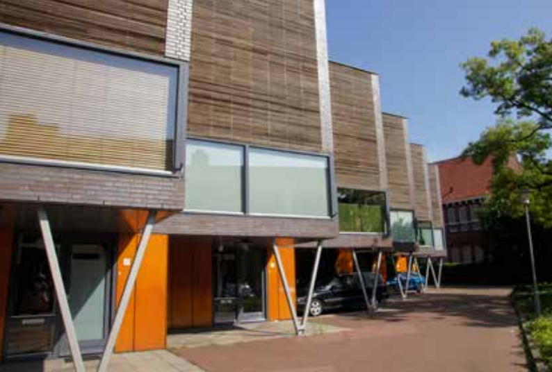
Foto EiB 53443 (*): De stadsvilla's aan de Julianastraat.
