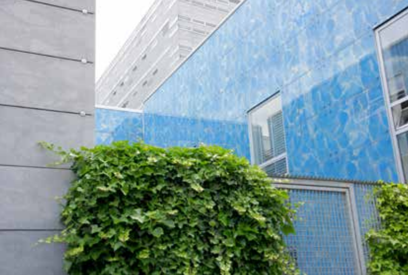
Foto EiB 53457 (*): Detail van de nieuwbouw aan de Zwembadweg.
