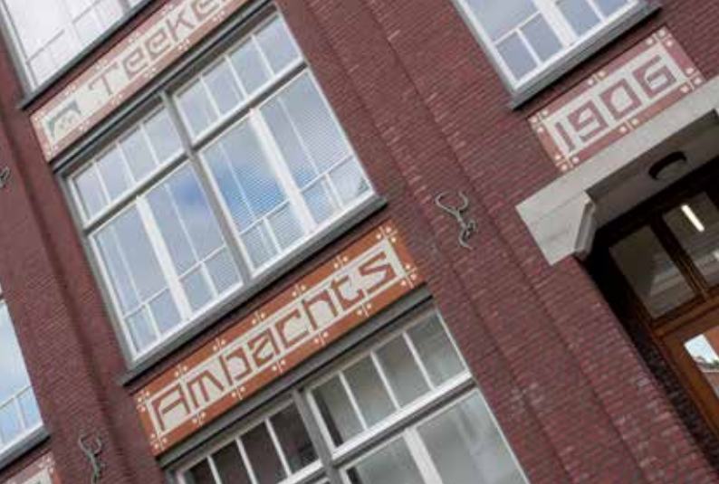
Foto EiB 53436 (*): Detail van de nieuwe gevel aan de Sint Catharinastraat.
