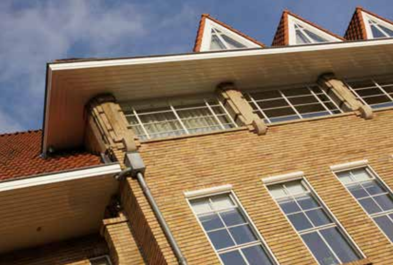
Foto EiB 53418 (*): De gevel van het gerenoveerde St Martha met extra dakkapellen.
