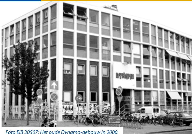
Foto Eib 30507: Het oude Dynamo-gebouw in 2000.
