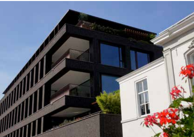
Foto EiB 53412 (*): Het nieuwe appartementencomplex 'Bilderdijk Living'.
