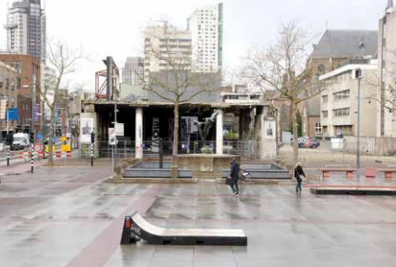
Foto EIB 54681 (*): De gesloopte noordwand van het Stadhuisplein.
