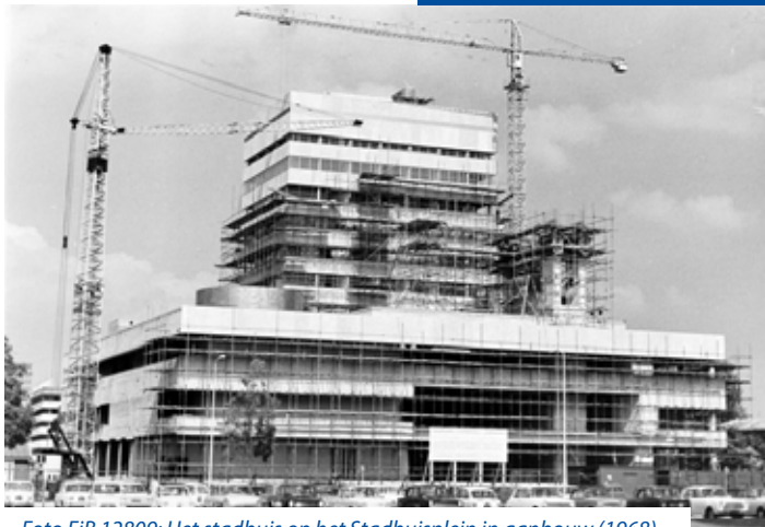
Foto EIB 12809: Het stadhuis op het Stadhuisplein in aanbouw (1968).
