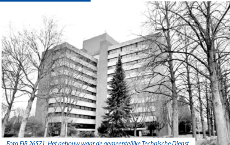
Foto EiB 26571: Het gebouw waar de gemeentelijke Technische Dienst gevestigd was.
