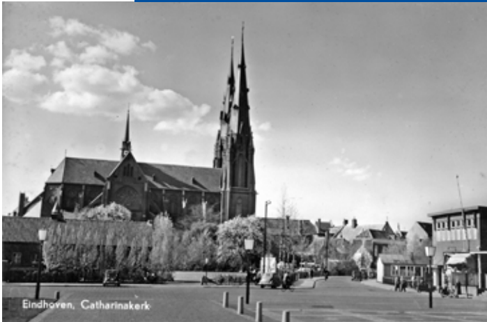
Foto EiB 22978: Zicht op de Catharinakerk voor de bouw van de noordwand.
