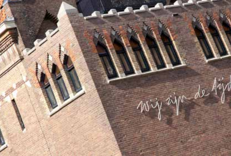
Foto EiB 53399 (*): Detail van de muur van het vroegere schoolgebouw.
