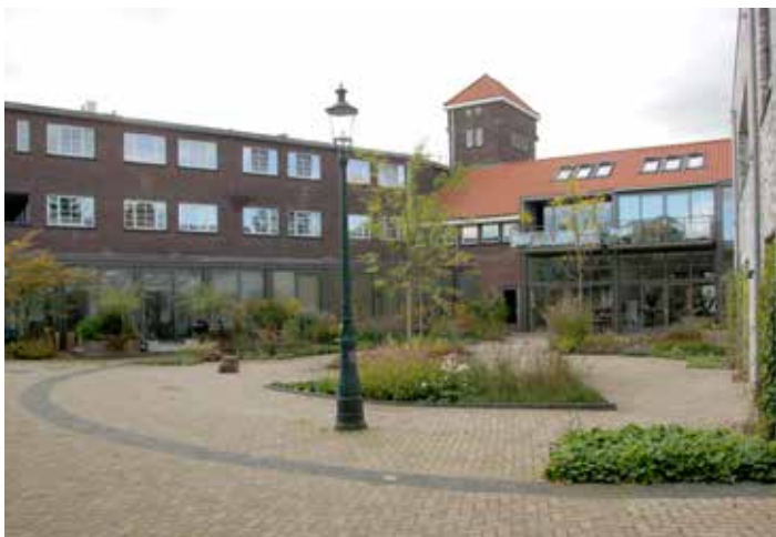
Foto EiB 53401 (*): Nieuwbouw op het voormalige NRE-terrein.
