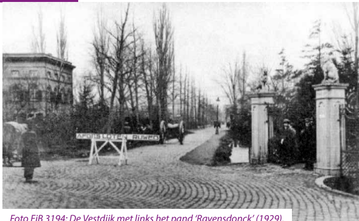
Foto EiB 3194: De Vestdijk met links het pand 'Ravensdonck' (1929).
