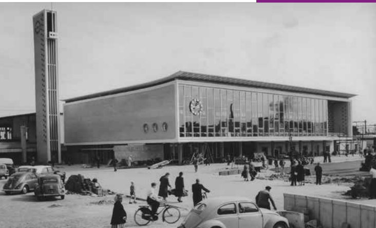
Foto EIB 21989: Het station in 1956, toen de laatste bouwactiviteiten verricht werden.
