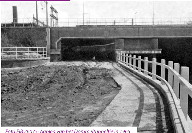
Foto EiB 26075: Aanleg van het Dommeltunneltje in 1965.
