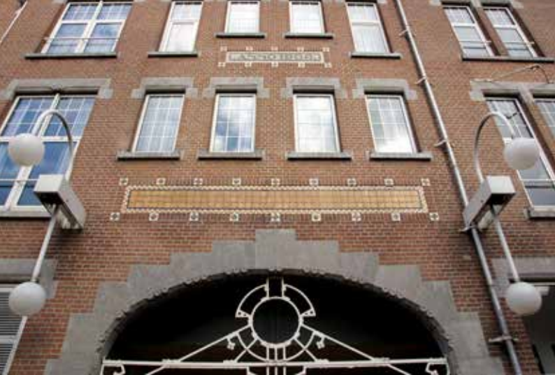
Foto EiB 53386 (*): Detail van het gebouw 'De Stadspoort'.
