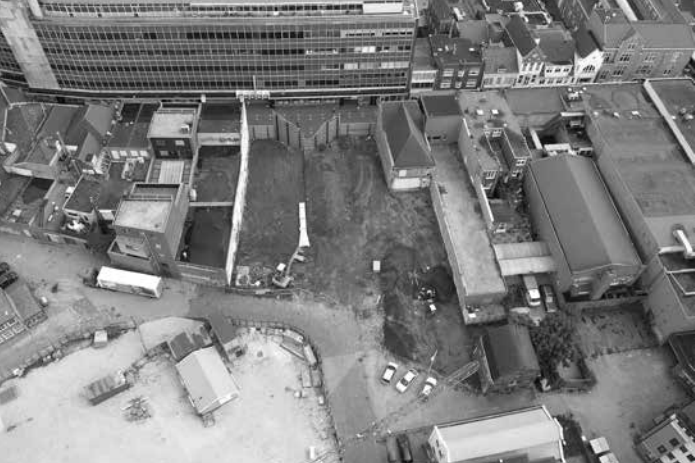
Foto EiB 18619: Het winkelgebied Admirant in aanleg. Midden boven zien we het tracé van de oude Vijksteeg richting de Vrijstraat.
