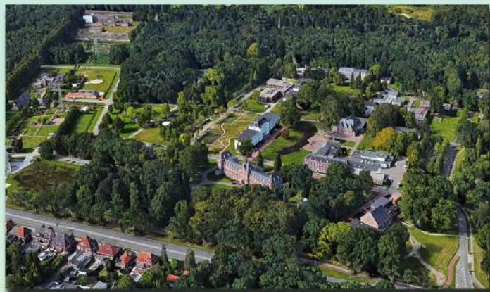
De Grote Beek zoals het er nu uitziet. De hoofdingang is verplaatst naar de rechterzijde van het Ketelhuis. Het hoofgebouw en het Ketelhuis zijn op beide afbeeldingen goed zichtbaar.
