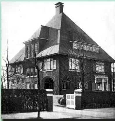
Huize Benvenuta aan de Parklaan 81 in het Villapark. Oorspronkelijk was dit de villa van Charles de Haes.
