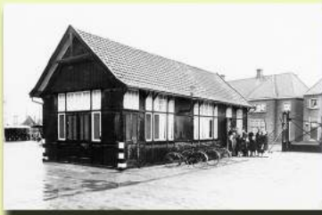
Deze foto is gemaakt in 1941. In dit gebouwtje zat vanaf de twintigste jaren de Philips Gezondheidszorg. In 1942 wordt het vervangen door een stenen gebouw: de Polikliniek Strijp.
